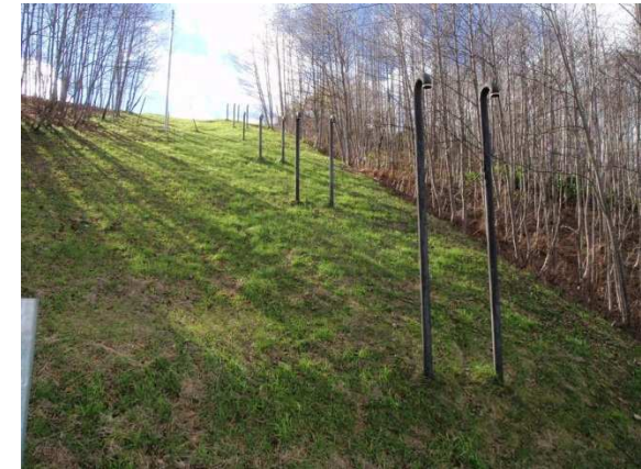
パイプライン (調圧施設)
