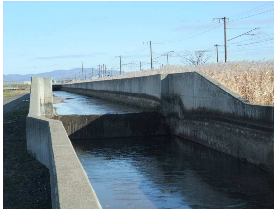
開水路 (落差工)
